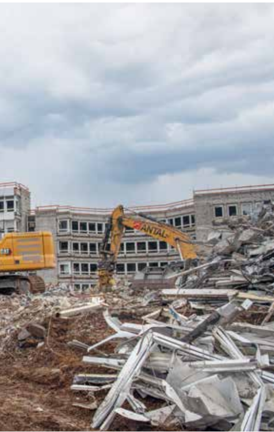
Unten: Mittlerweile ist der Abriss in vollem Gang.
