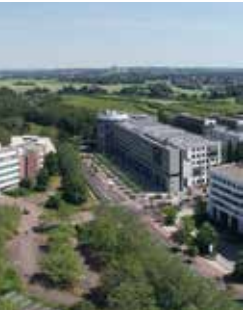
Links: Das Lurgi-Areal im Mertonviertel vor Abrissbeginn.
