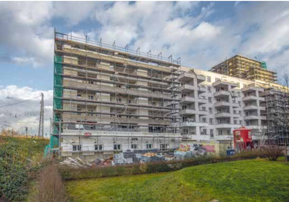
Im „Schwedler-Carree II“ entstehen derzeit 81 geförderte Wohnungen.
