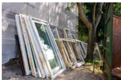
Am Morgen werden die alten Fenster ausgebaut...
