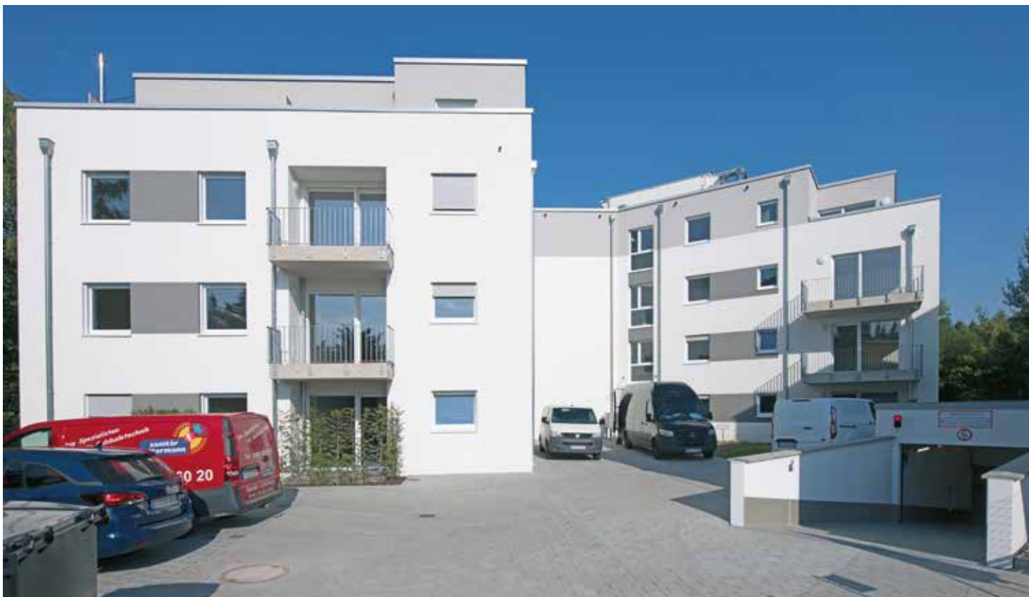
Das neue Gebäude für Geflüchtete und Wohnungslose im Oberschelder Weg.
